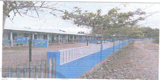
MIM Tamiang, dilihat dari samping depan (memanjang)
