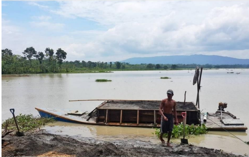
Gambar 4.7 Pengerukan Sedimen dengan Metode Manual
