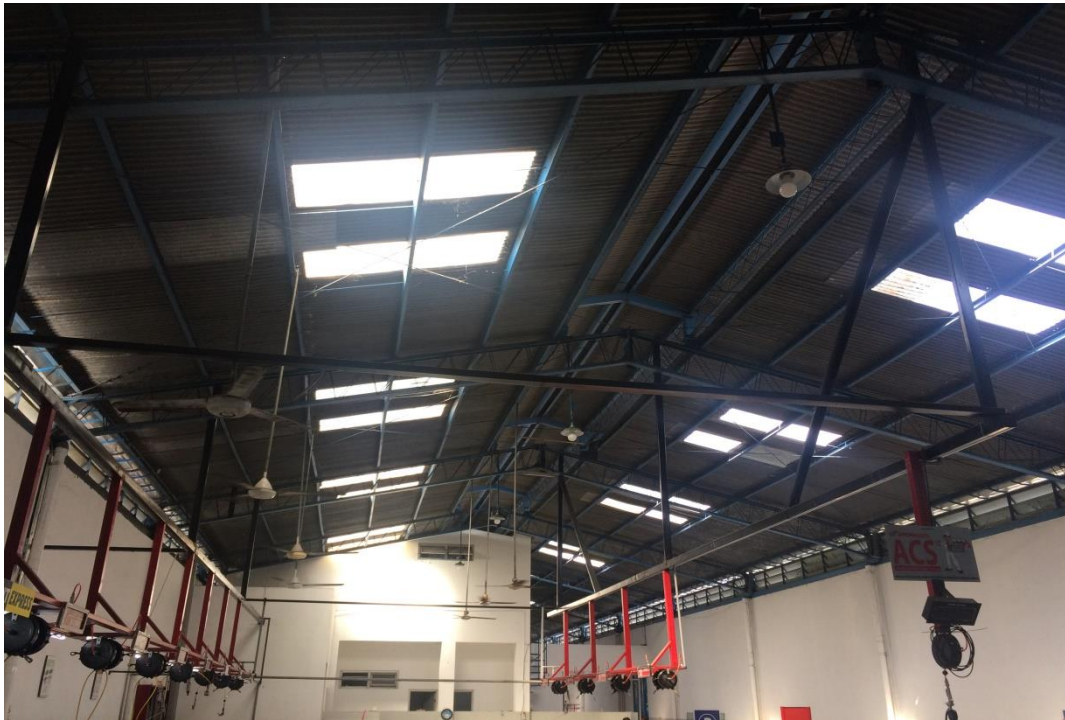
Gambar Lampiran 4 – Bangunan Penyimpanan Limbah Pelumas Bekas
