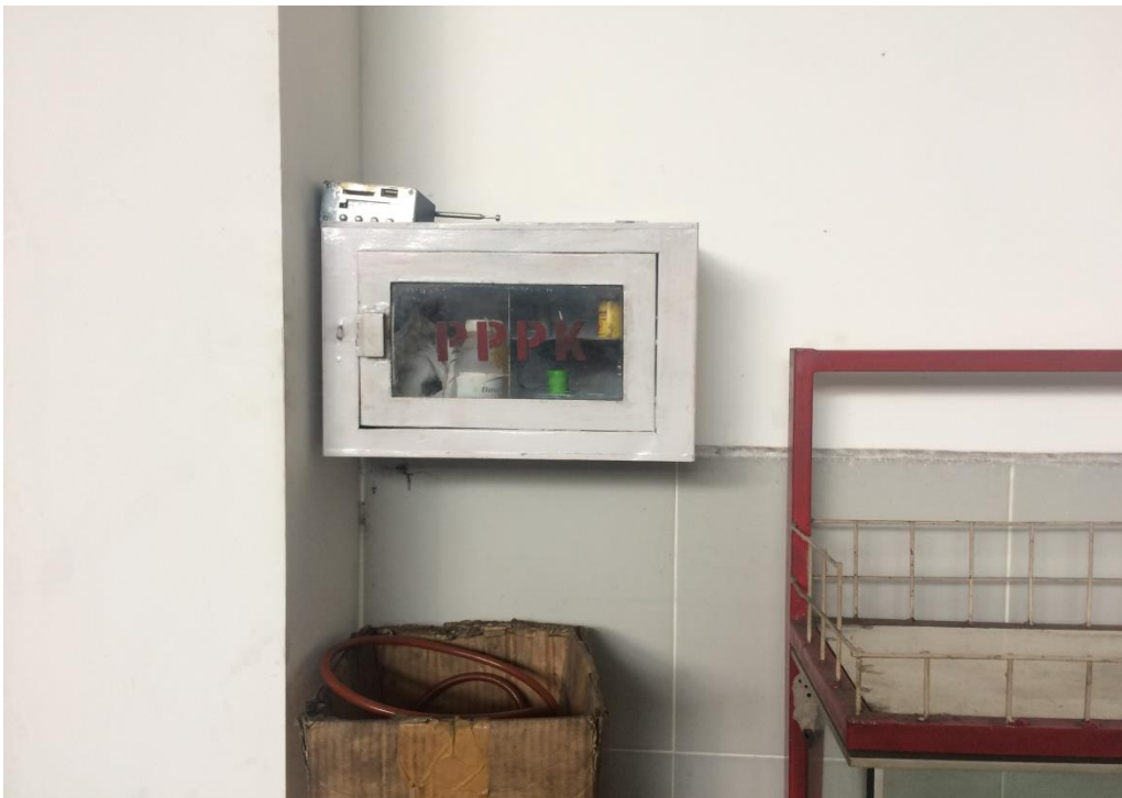
Gambar Lampiran 4 – Fasilitas Pertolongan Pertama Bangunan Penyimpanan Limbah Pelumas Bekas
