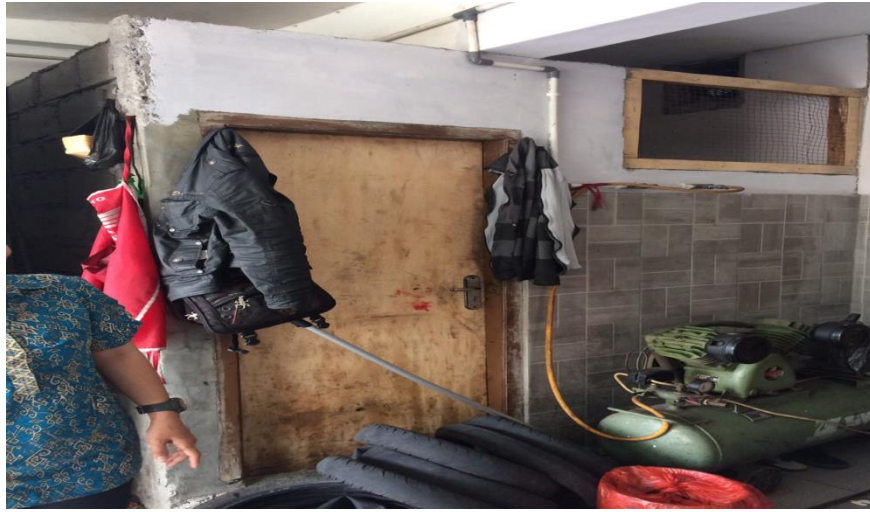
Gambar 4.13 Bangunan penyimpanan bengkel perusahaan Z, tidak menggunakan plafon dan memiliki ventilasi.
