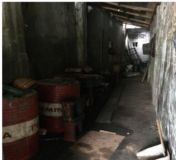
Gambar 4.10 Bangunan penyimpanan limbah pelumas bekas dari bengkel perusahaan X
