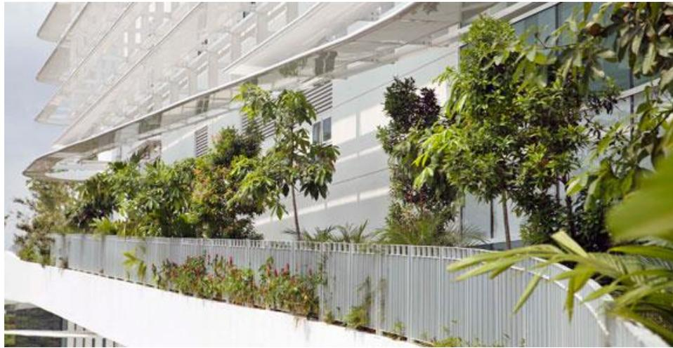
Gambar 2.35 *Shading* yang Menjadi Media Tanam Pada Fasad Solaris Tower
