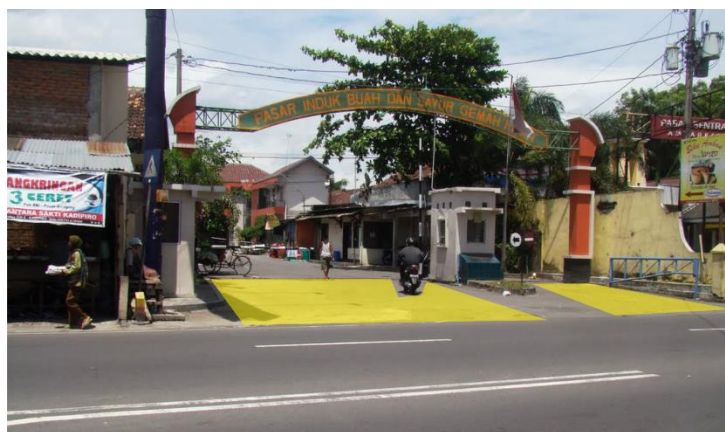
Gambar 18 : Eksisiting Entrance Sumber : Penulis, 2018
