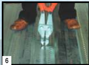
6 Sambungan pada Union Floor Deck W-1000® diperkaku dengan jepitan
