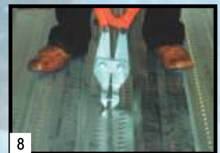
8 Sambungan Union Floor Deck W-1000® dapat diperkaku dengan jepitan
