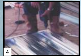
4 Endstop metal dipasang pada Union Floor Deck W-1000®
