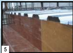
5 Kakukan Union Floor Deck W-1000® dengan paku pada bekisting
