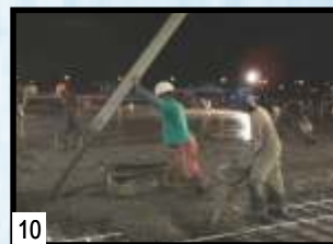
10 Penuangan beton
