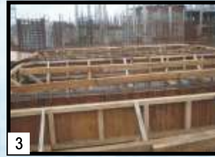
3 Letakkan Union Floor Deck W-1000® di atas penyangga sementara
