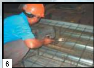
6 Kakukan Union Floor Deck W-1000® pada bagian tepi dengan las titik di balok baja
