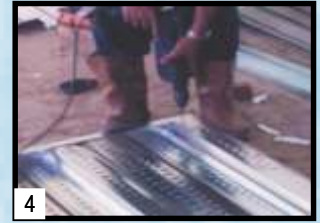
4 Endstop dipasang pada Union Floor Deck W-1000®
