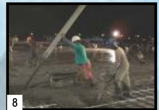
8 Penuangan beton
