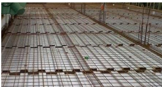
Gambar 3.8 Penulangan Pelat Lantai Dengan Bondek
