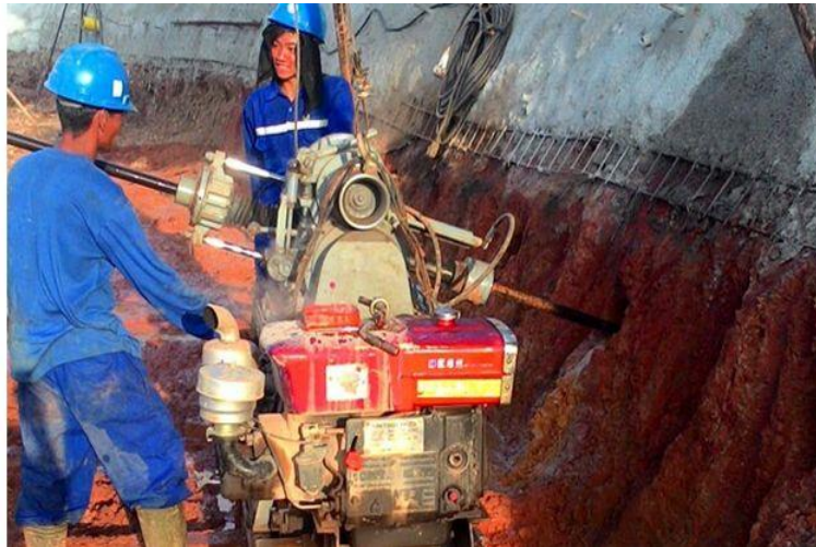
Gambar 3.18 Pemasangan Nail
