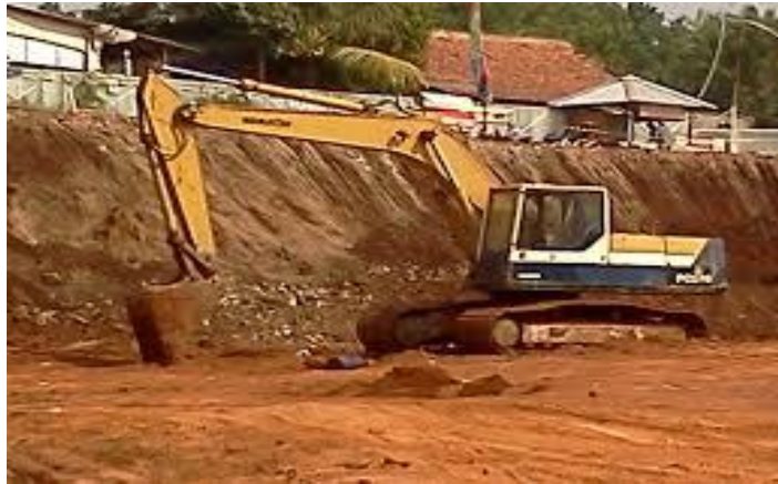
Gambar 3.16 Pekerjaan Galian Tanah
