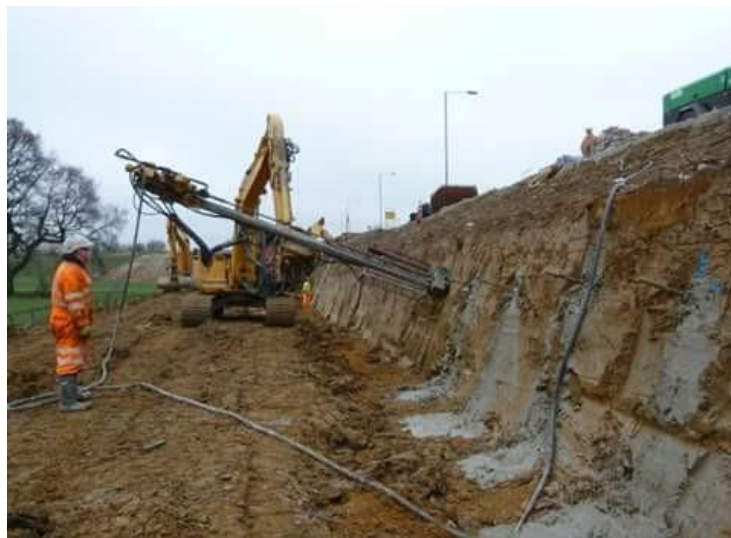
Gambar 3.17 Pengeboran Tanah Untuk Nail
