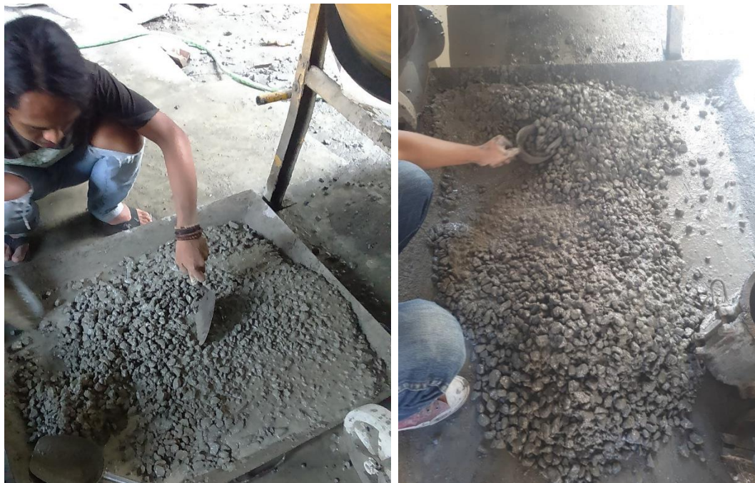
Gambar L-18.1 Pembuatan Campuran Beton
