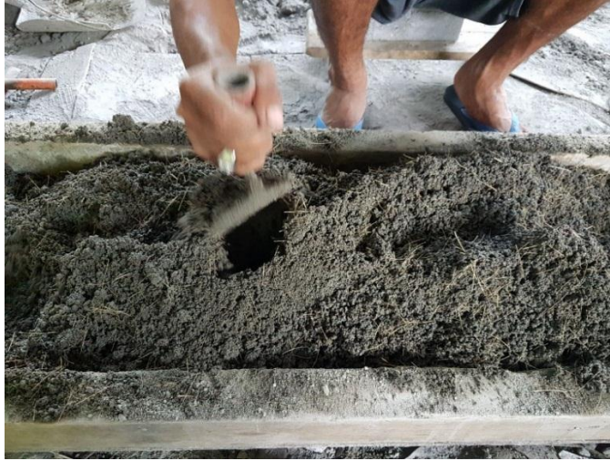
Gambar L-4.1 Proses Pencampuran Bahan Penyusun Paving Block
