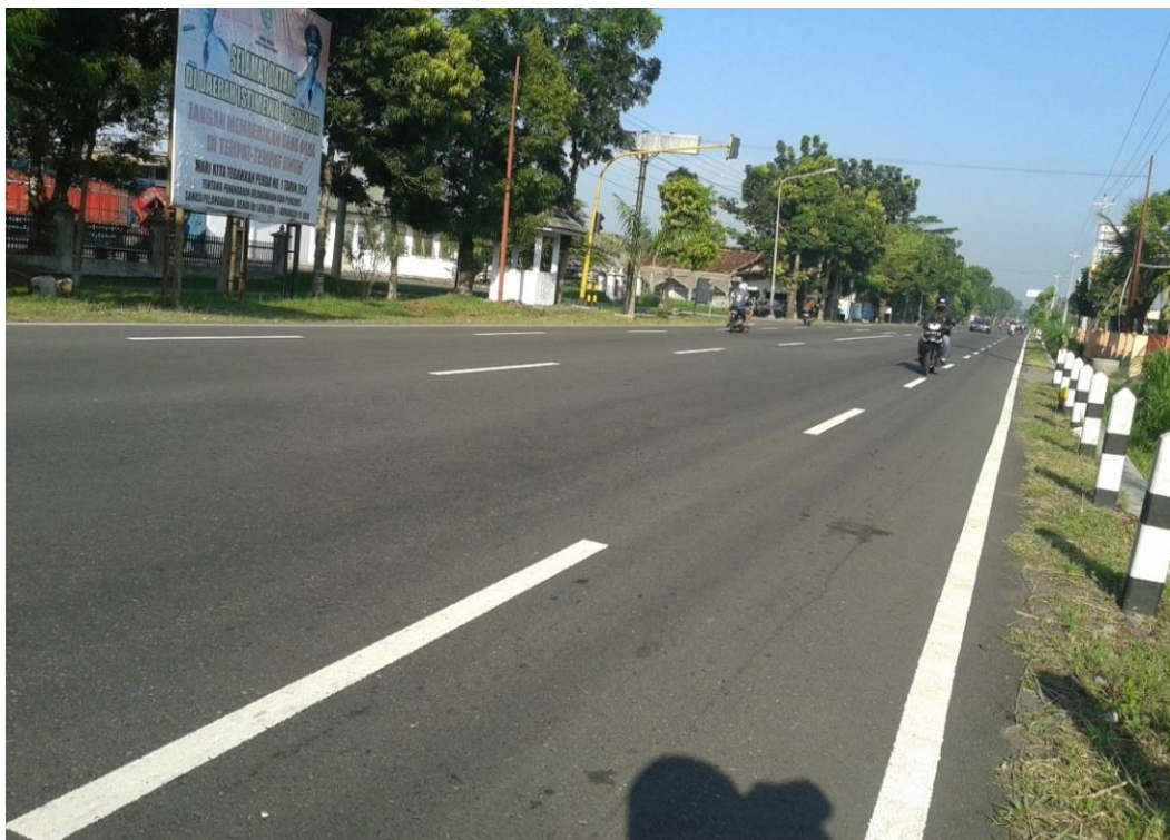
Gambar 1.1 Foto Ruas Jalan Raya Jogja - Purworejo
