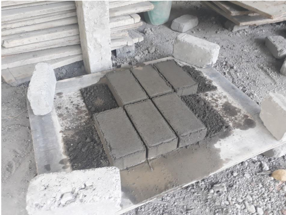
Gambar L-9.5 Benda Uji Setelah Pencetakan
