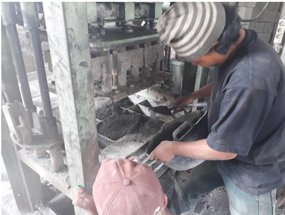
Gambar L-9.4 Penuangan Campuran Bahan ke Dalam Cetakan Paving Block dalam Mesin Press Paving Block pada Pembuatan Benda Uji
