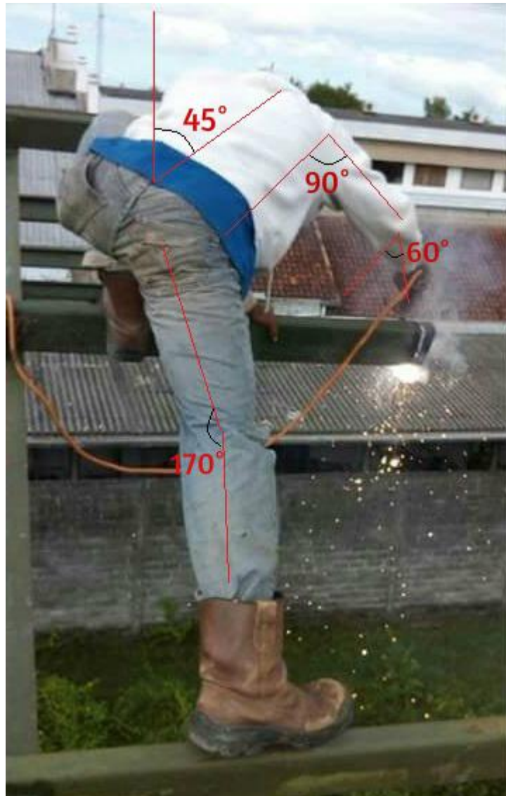
Gambar 4.7 Postur Kerja pemotongan besi
