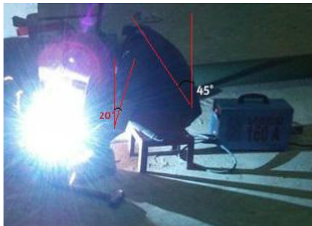
Gambar 4.8 Postur Kerja pada peyambungan besi pondasi
