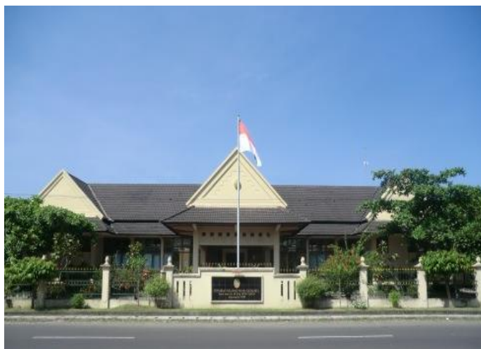
gedung lama PTUN Yogyakarta
