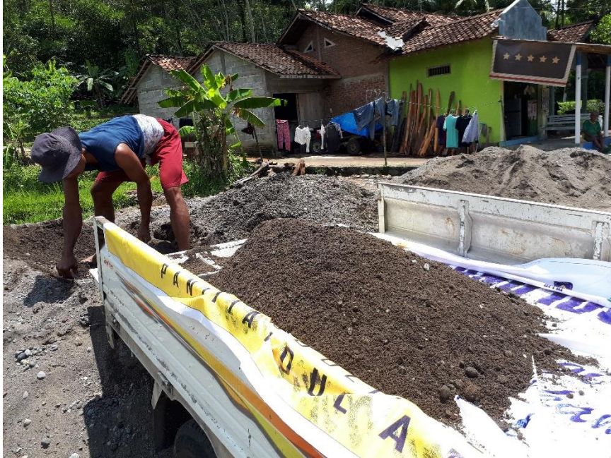
Gambar L-1.1 Proses Persiapan Pengangkutan Material Pasir Progo
