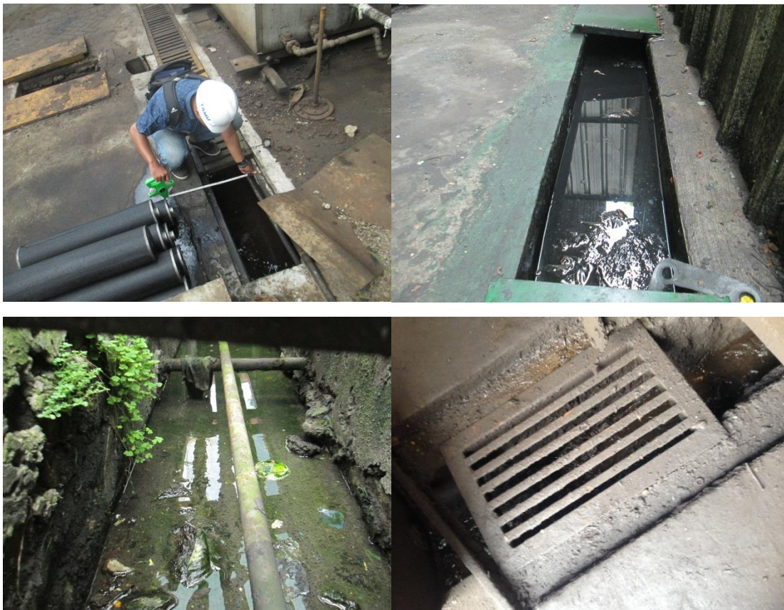
Gambar 4 8 Dokumentasi Saluran Air Limbah Eksisting
