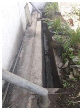
Gambar 5.6 Outlet Jaringan Perpipaan Air Hujan Eksisting
