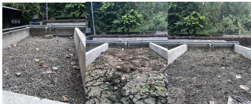
Gambar 4.22 Sludge Drying Bed (Tampak atas) di unit IPAL Rumah Sakit “JIH” Yogyakarta
