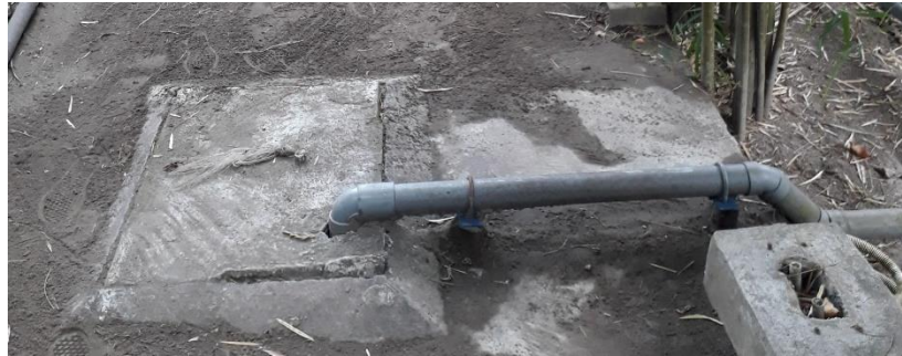
Gambar 4.5 Tampungan air limbah dari grease trap di IPAL Rumah Sakit “JIH” Yogyakarta
