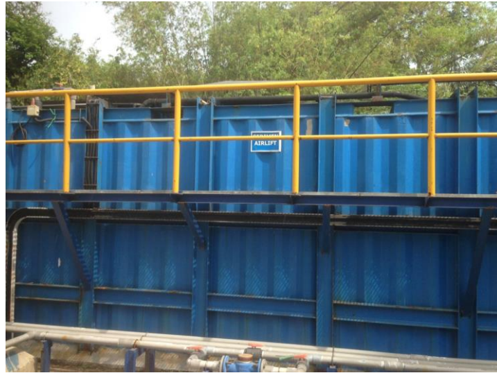
Gambar 4.14 Bak sedimentasi aerobik di unit IPAL Rumah Sakit “JIH” Yogyakarta
