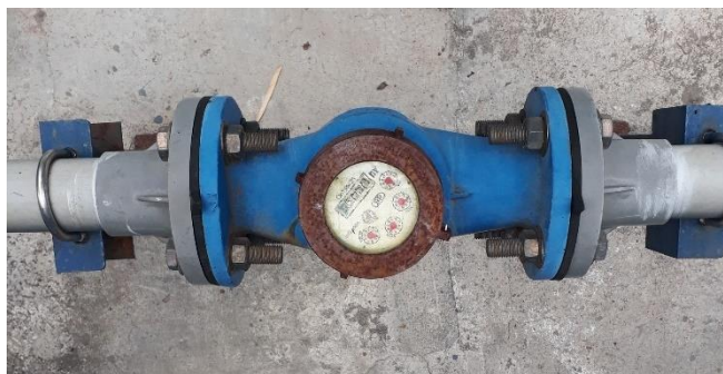
Gambar 4.6 Flow meter inlet air limbah di IPAL Rumah Sakit “JIH” Yogyakarta
