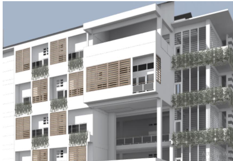
Gambar 3.47 Shading Massa Bangunan menghadap arah barat-timur
