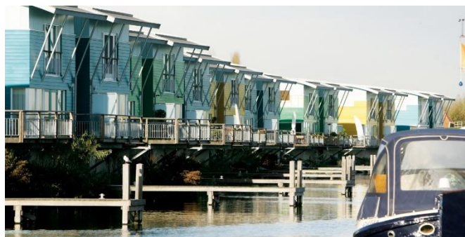
Gambar 2.23 Rumah Amphibi dengan konstruksi tiang penahan baja di Maasbommel, Belanda
