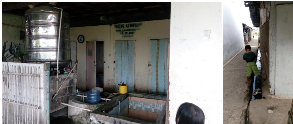
Gambar 1.3 Kanan: MCK umum di Kampung Kandang; Kiri: Warga yang buang air kecil sembarangan dikarenakan jarak ke MCK yang jauh. Sumber : Penulis (2017)
