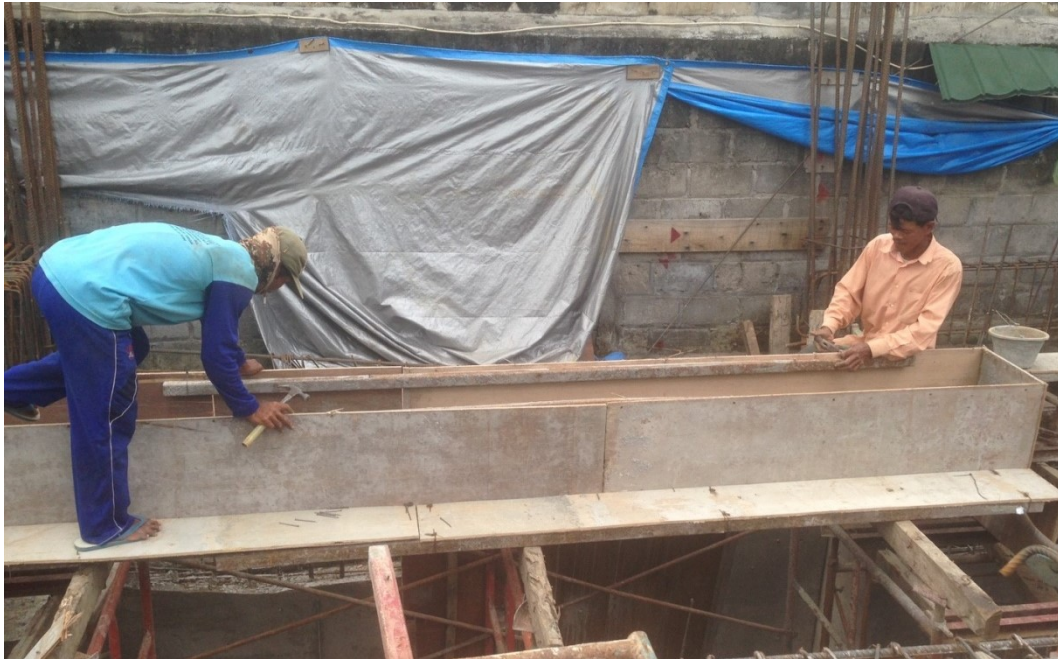
Gambar L-3.1 Bekisting Balok
