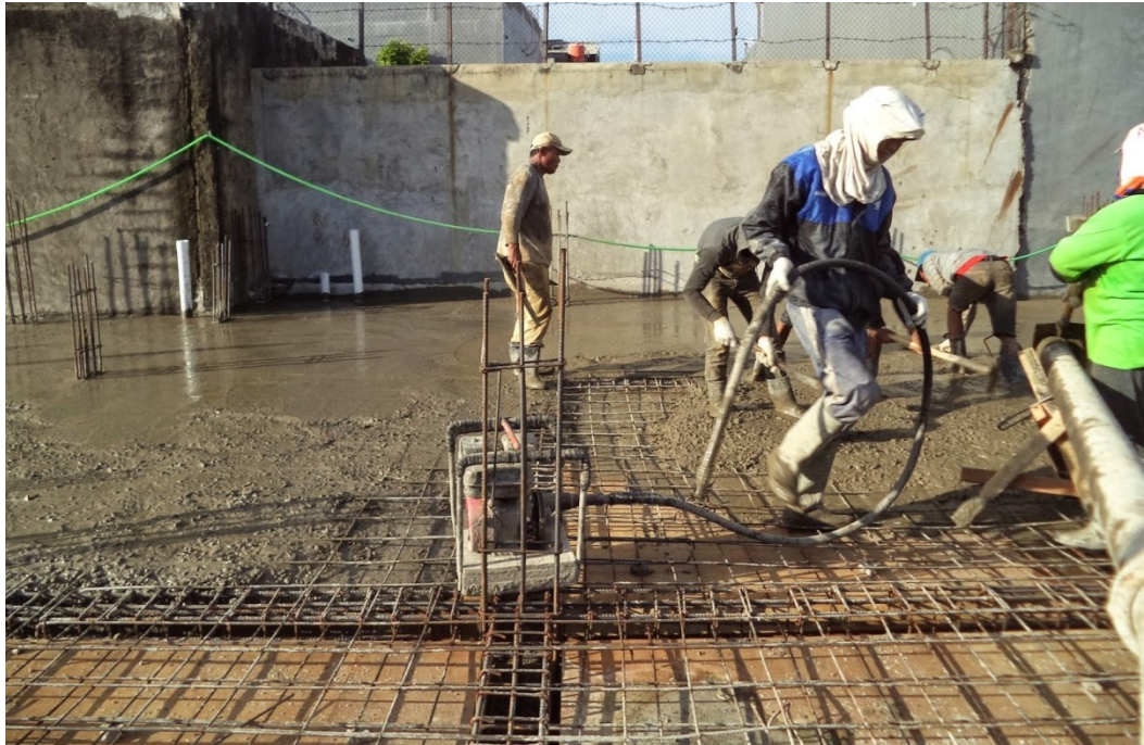
Gambar L-3.5 Pengecoran
