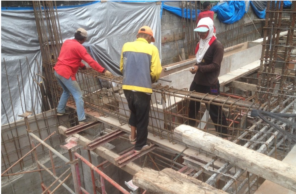
Gambar L-3.3 Pembesian Balok
