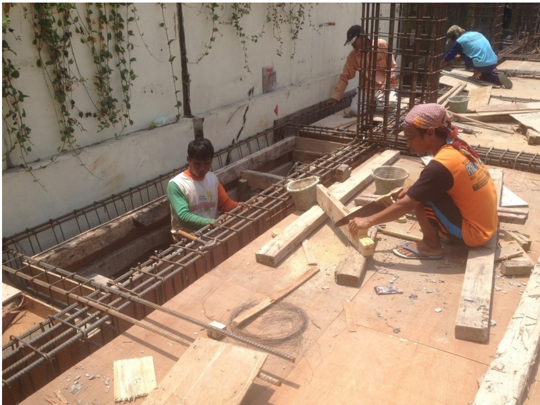
Gambar L-3.2 Bekisting Plat Lantai
