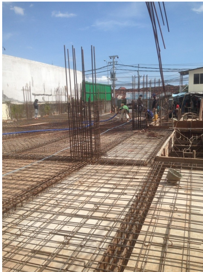
Gambar L-3.4 Pembesian Plat Lantai
