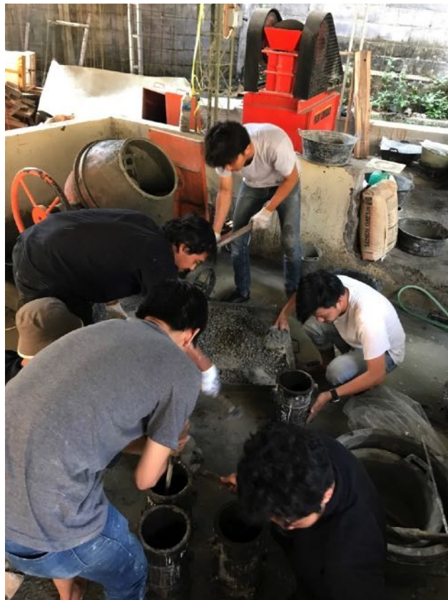
Gambar L 3-4.6 Pemasakan Adukan Beton dalam Silinder
