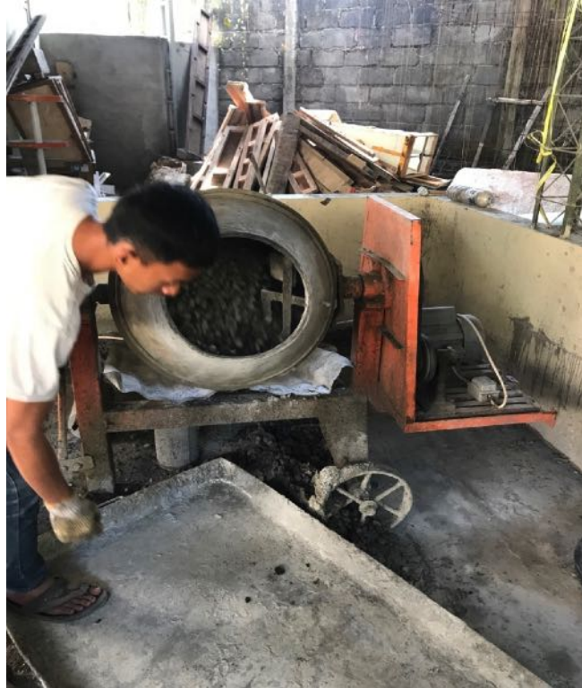
Gambar L 3-4.3 Pembuatan Adukan Beton
