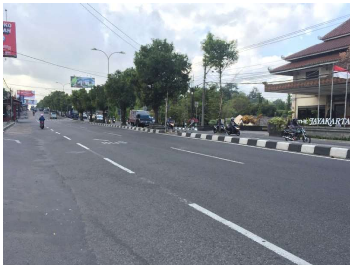
Gambar 5.2 Kondisi Jalan Janti-Prambanan dari Arah Barat KM 7+750
