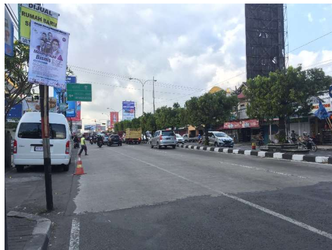
Gambar 5.4 Kondisi Jalan Janti-Prambanan dari Arah Barat KM 8+750
