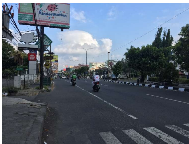
Gambar 5.5 Kondisi Jalan Janti-Prambanan dari Arah Timur KM 8+750
