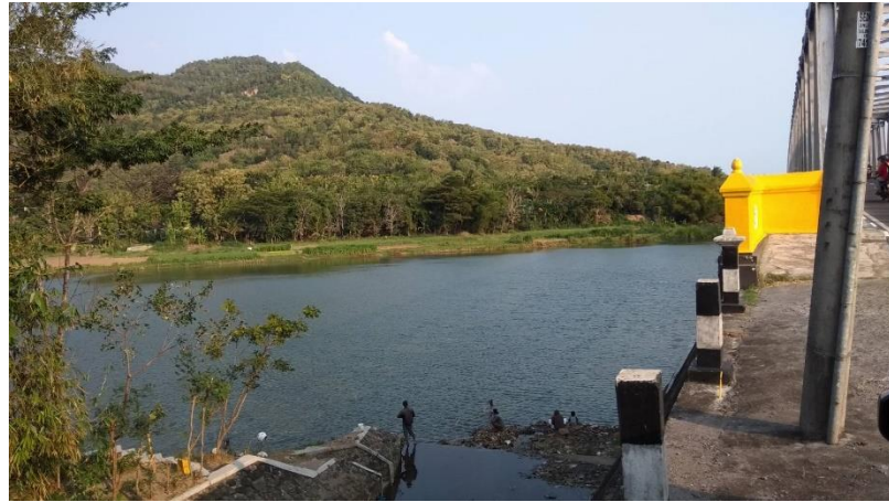
Gambar 3.17 Site 5 (Jembatan Kretek)
