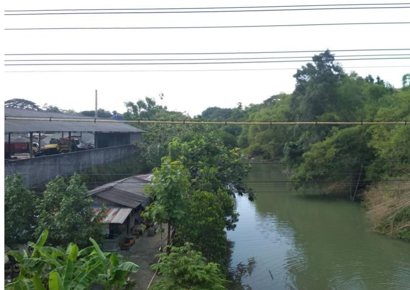
Gambar 3.3 Site 1 (Jembatan Panas Kaliopak)
