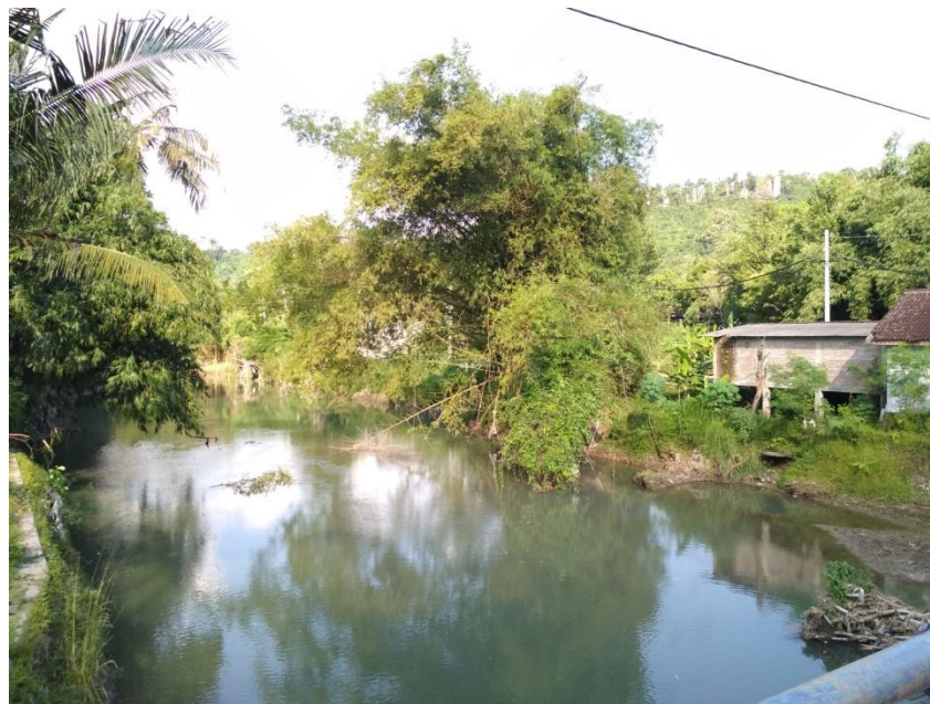
Gambar 3.5 Site S.Gawe (Jembatan Bintaran Kulon)
