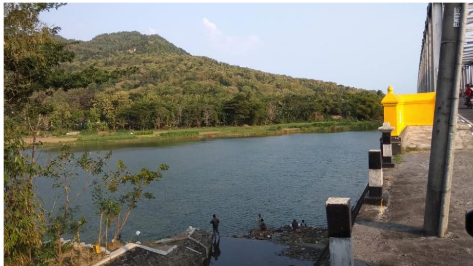
Gambar 3.19 Site 5 (Jembatan Kretek)
