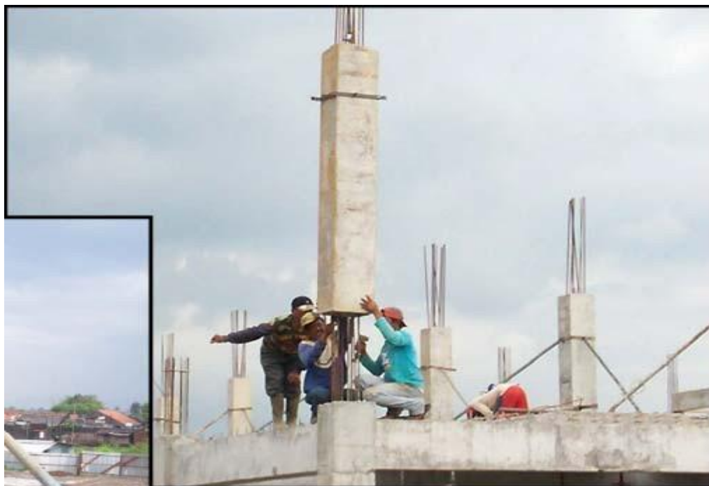
Gambar 3.2 Pemasangan Kolom Pracetak (Sumber: reyhan, 2017 )
