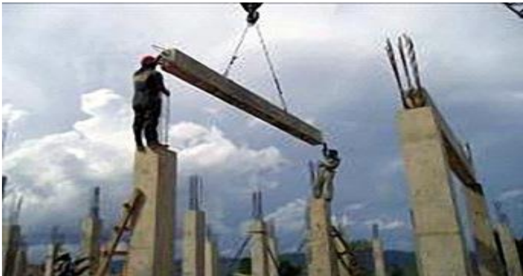
Gambar 3.3 Pemasangan Balok Precetak
