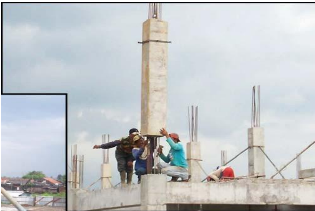
Gambar 3.2 Pemasangan Kolom Pracetak (Sumber: reyhan, 2017 )
