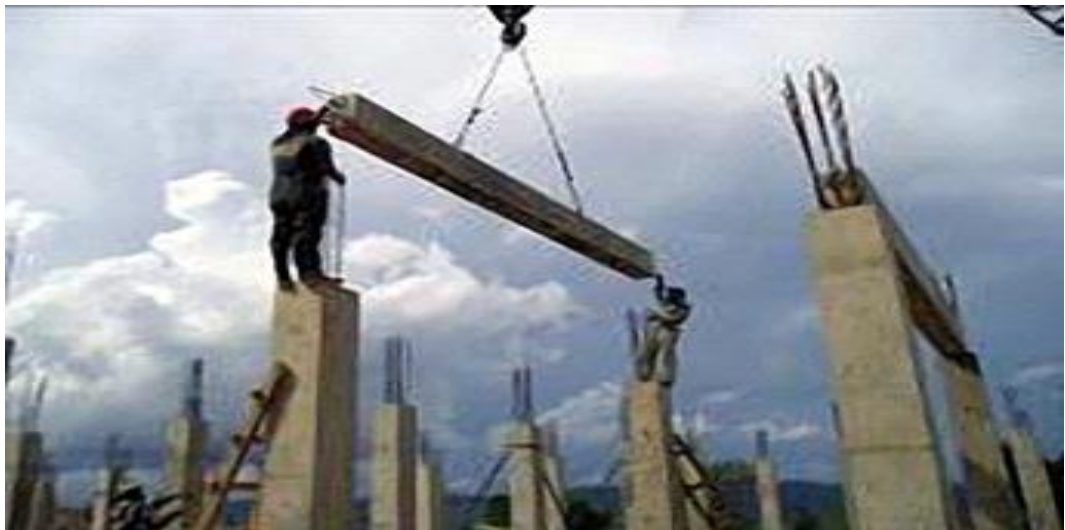
Gambar 3.3 Pemasangan Balok Precetak
