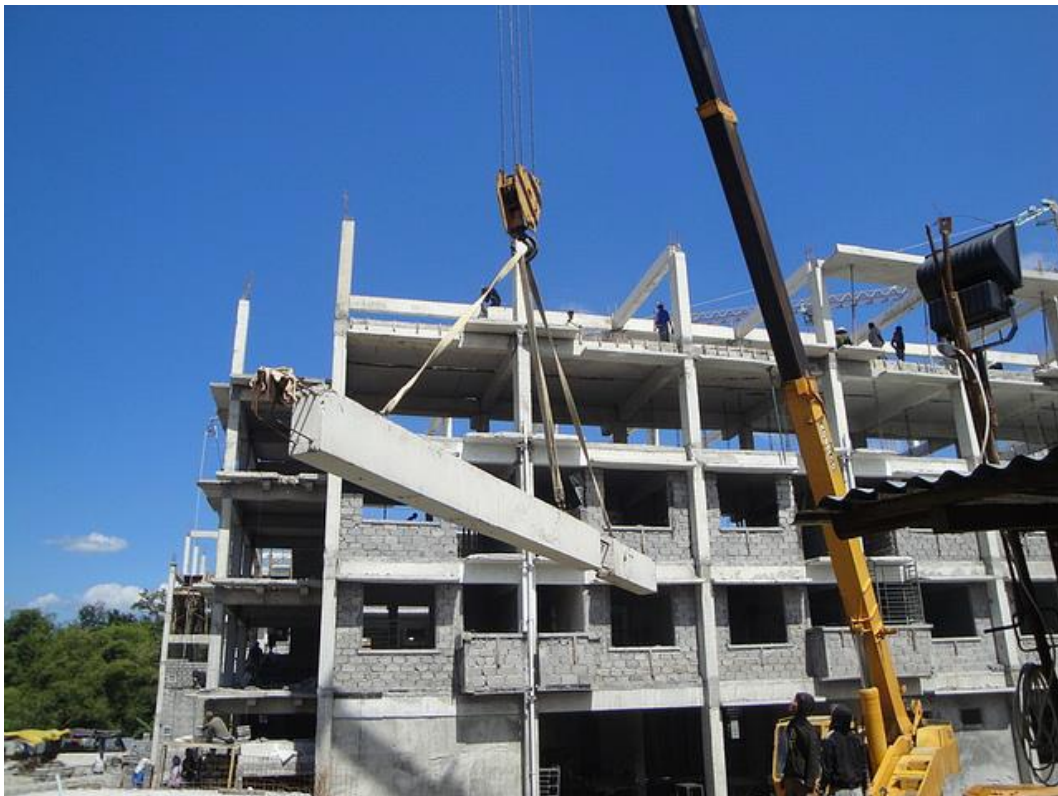
Gambar 3.1 Langsir Kolom Pracetak (Sumber: reyhan, 2017 )
