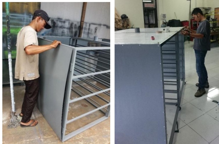
Gambar 4.3.3 Pemasangan Saluran Pembagi Udara (kiri) dan Dinding Polikarbonat (kanan)
