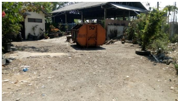
Gambar 4.1 Jalan Akses Masuk ke TPS 3R Gunugpring
