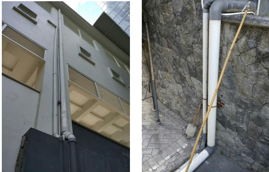
Gambar 4.1 (a) Talang Tegak dari Atap Gedung (b) Talang Tegak Bagian Bawah
