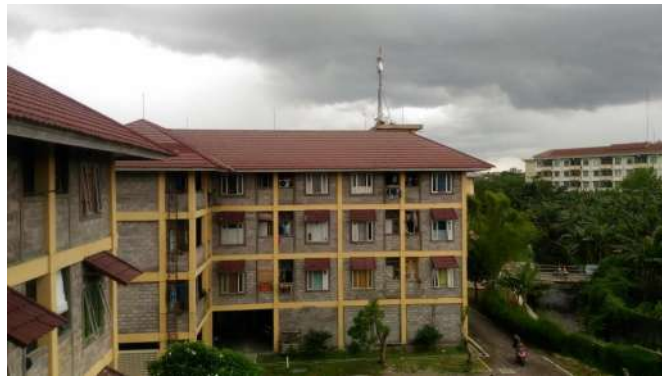
Gambar 5. 3. Tampak Belakang Gedung Rusunawa Gemawang Blok B
