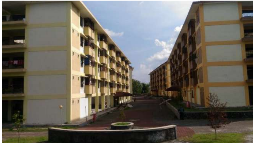
Gambar 5. 1. Tower Gedung Rusunawa Jongke
