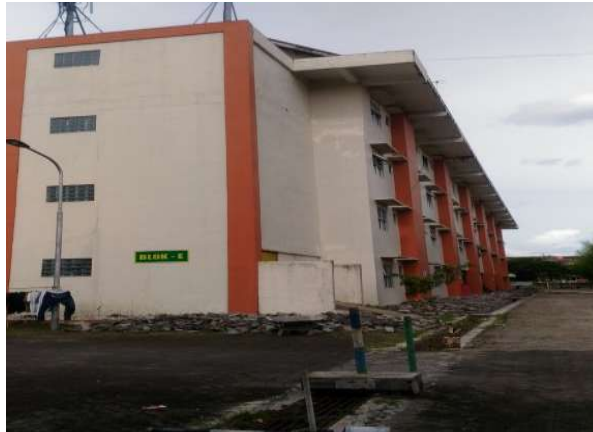
Gambar 5. 9. Gedung Rusunawa Dabag Blok E-F
