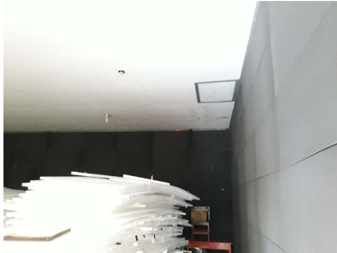
Gambar (4) Kondisi di dalam ruang perpustakaan setelah dipasang media peredam busa tebal 2 cm
