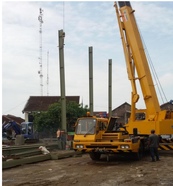
Gambar 4. Install Rangka Kolom
