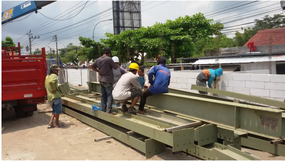
Gambar 3. Pemasangan Tali Pengait
