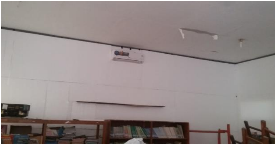
Gambar 4. Ruang Kelas Setelah Dipasang Alat Peredam Styrofoam
