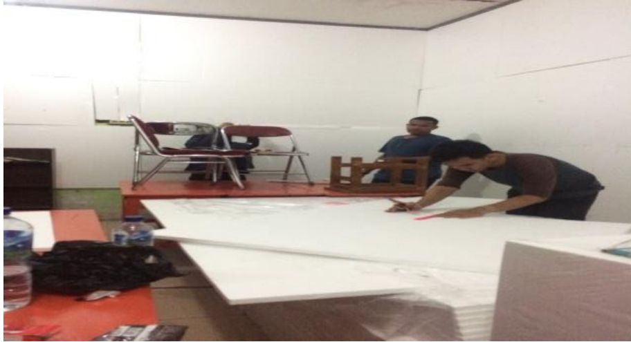
Gambar 1. Proses Pemasangan Alat Peredam Styrofoam
