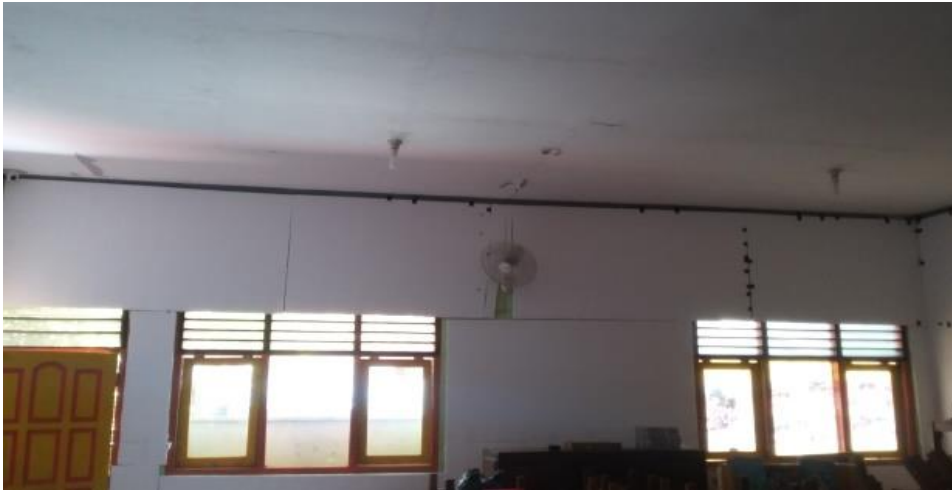
Gambar 6. Ruang Kelas Setelah Dipasang Alat Peredam Styrofoam
