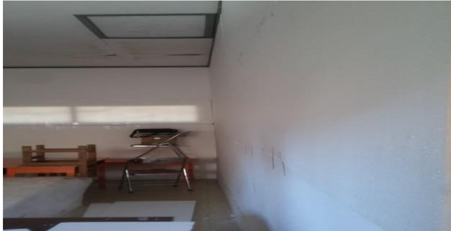
Gambar 3. Ruang Kelas Setelah Dipasang Alat Peredam Styrofoam
