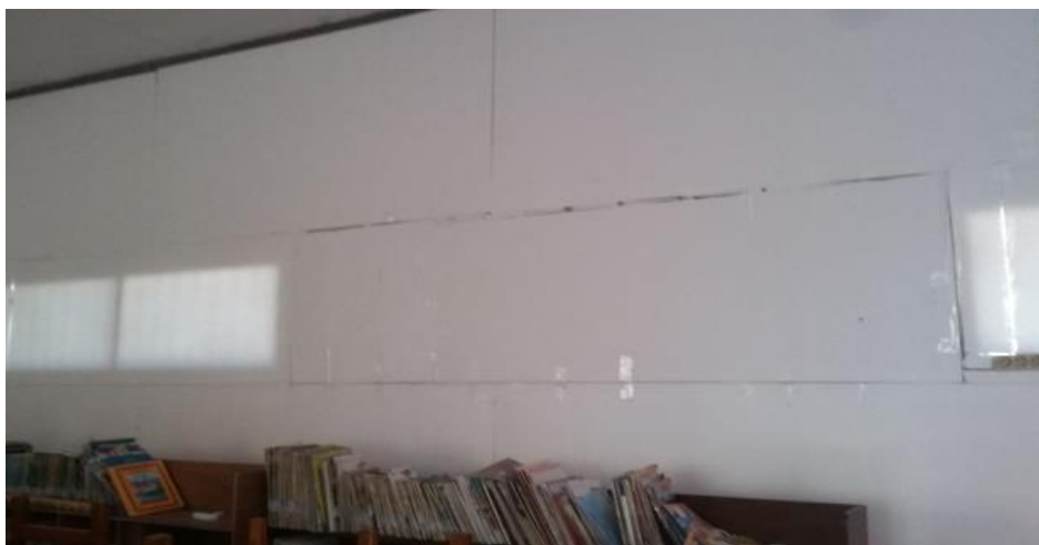
Gambar 5. Ruang Kelas Setelah Dipasang Alat Peredam Styrofoam
