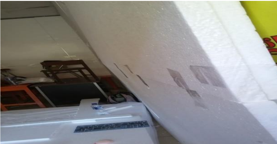
Gambar 7. Ruang Kelas Setelah Dipasang Alat Peredam Styrofoam 4 cm
