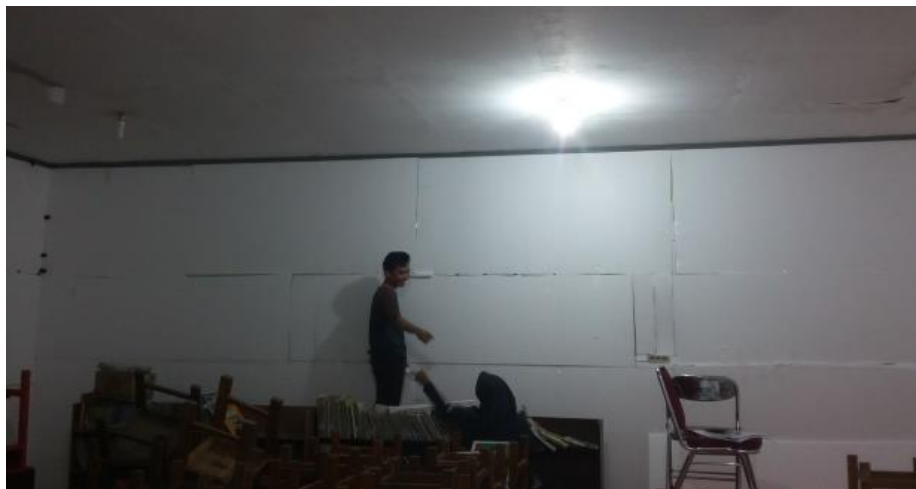
Gambar 2. Proses Pemasangan Alat Peredam Styrofoam
