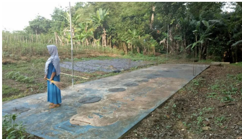
Gambar 4.9 IPAL Komunal Ganjuran
