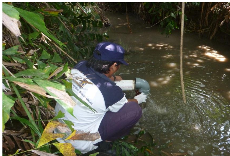
Gambar 4.10 Outlet IPAL Komunal Dusun Ganjuran
