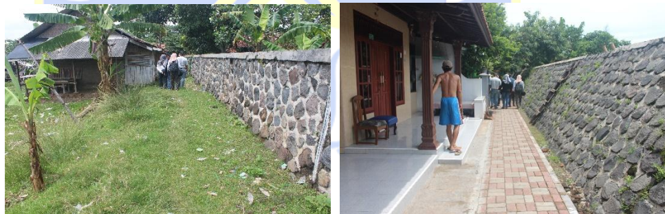
Gambar 2.1.19 Talud dari Arah Bantaran Sungai (kiri), dan Talud dari Arah Pemukiman Warga (kanan).
