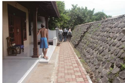
Rumah yang bersebeahan dengan tanggul sungai Sumber: Survey site, 2016
