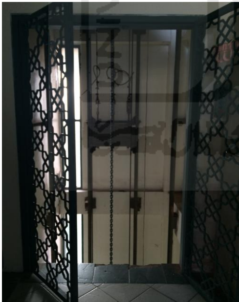
Kondisi di Area Lift Barang
