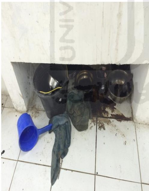
Kondisi di Area Lab. Jalan Raya
