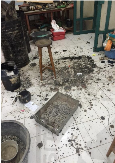
Kondisi di Area Lab. Jalan Raya
