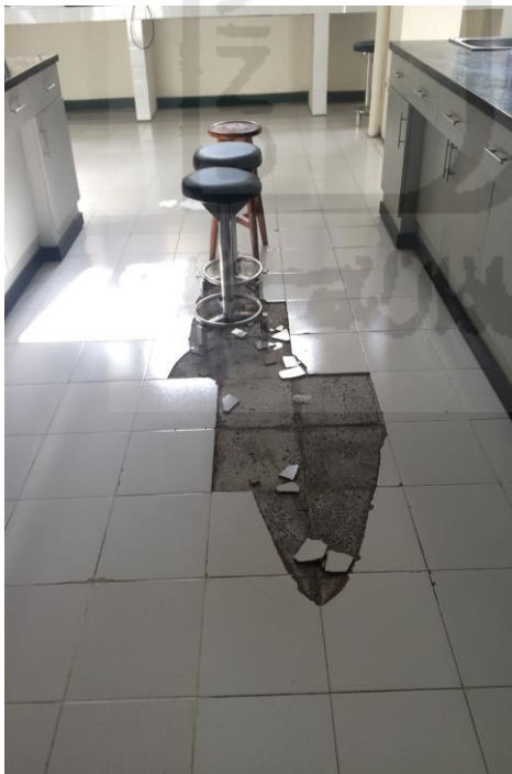
Kondisi Lantai di Lab. Bioteknologi
