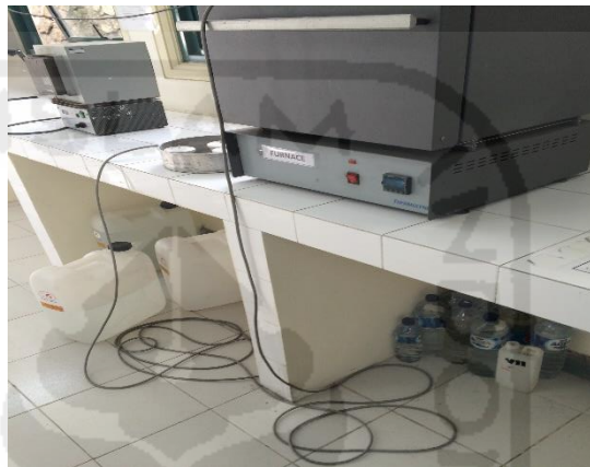
Gambar 4.11 Kondisi Instalasi Listrik
