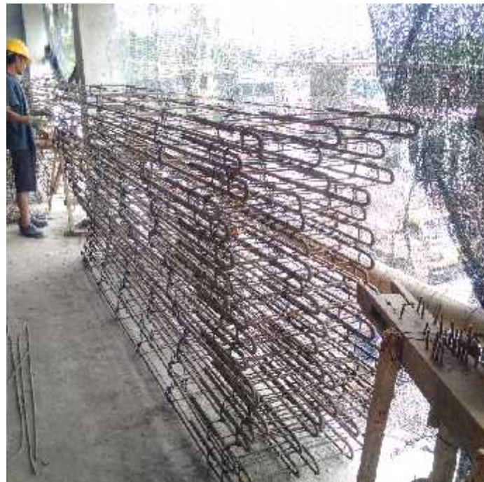
Lampiran 2.d Rakitan Besi flyslab
