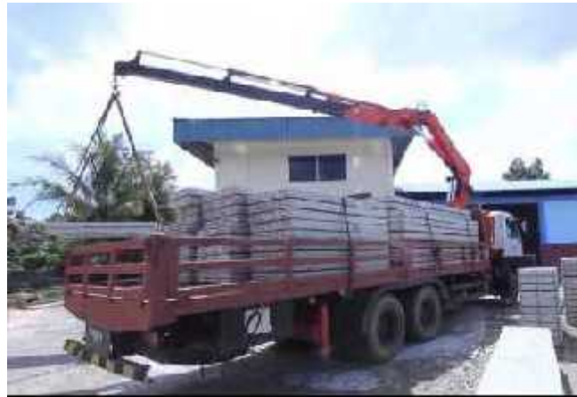
Gambar 3.5 Pengangkutan Pelat Beton Flyslab
