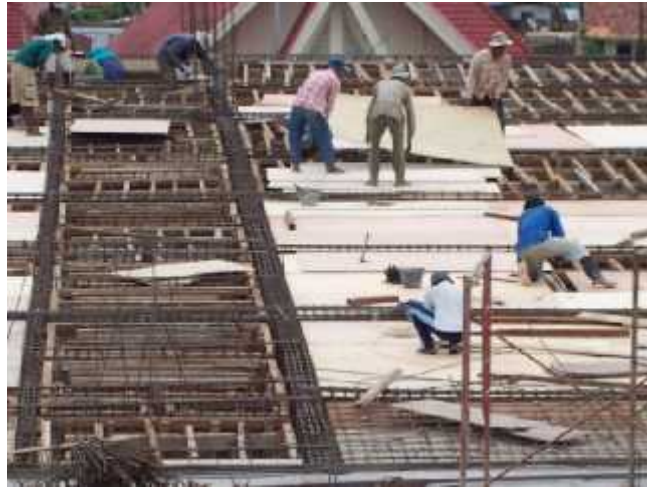
Gambar 3.2 Pemasangan Bekesting Pelat Lantai
