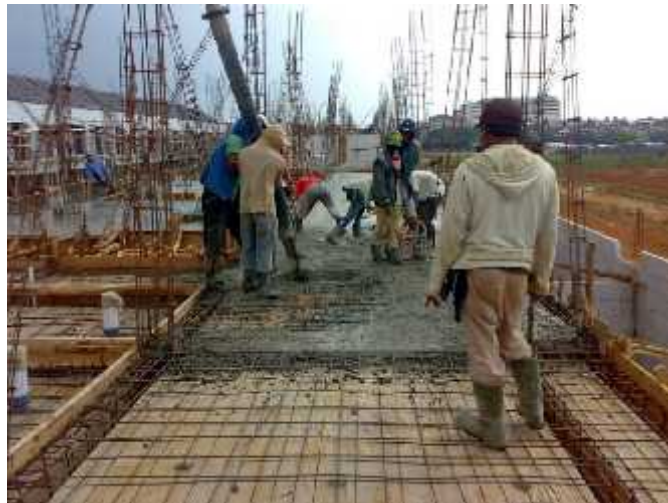
Gambar 3.1 Pengecoran Pelat Beton Konvensional
