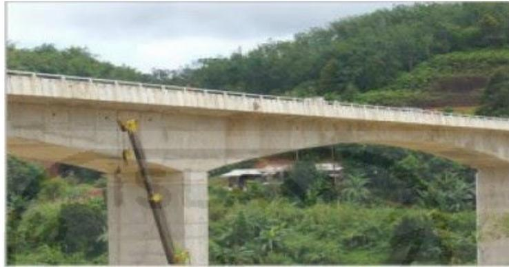
Gambar 2.7 Tinggi elemen *box girder* bervariasi
