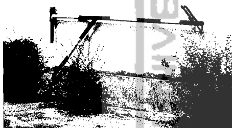
Gambar 34. Palang pembatas sekaligus pintu masuk dan keluar di Perumahan Minomartani.
