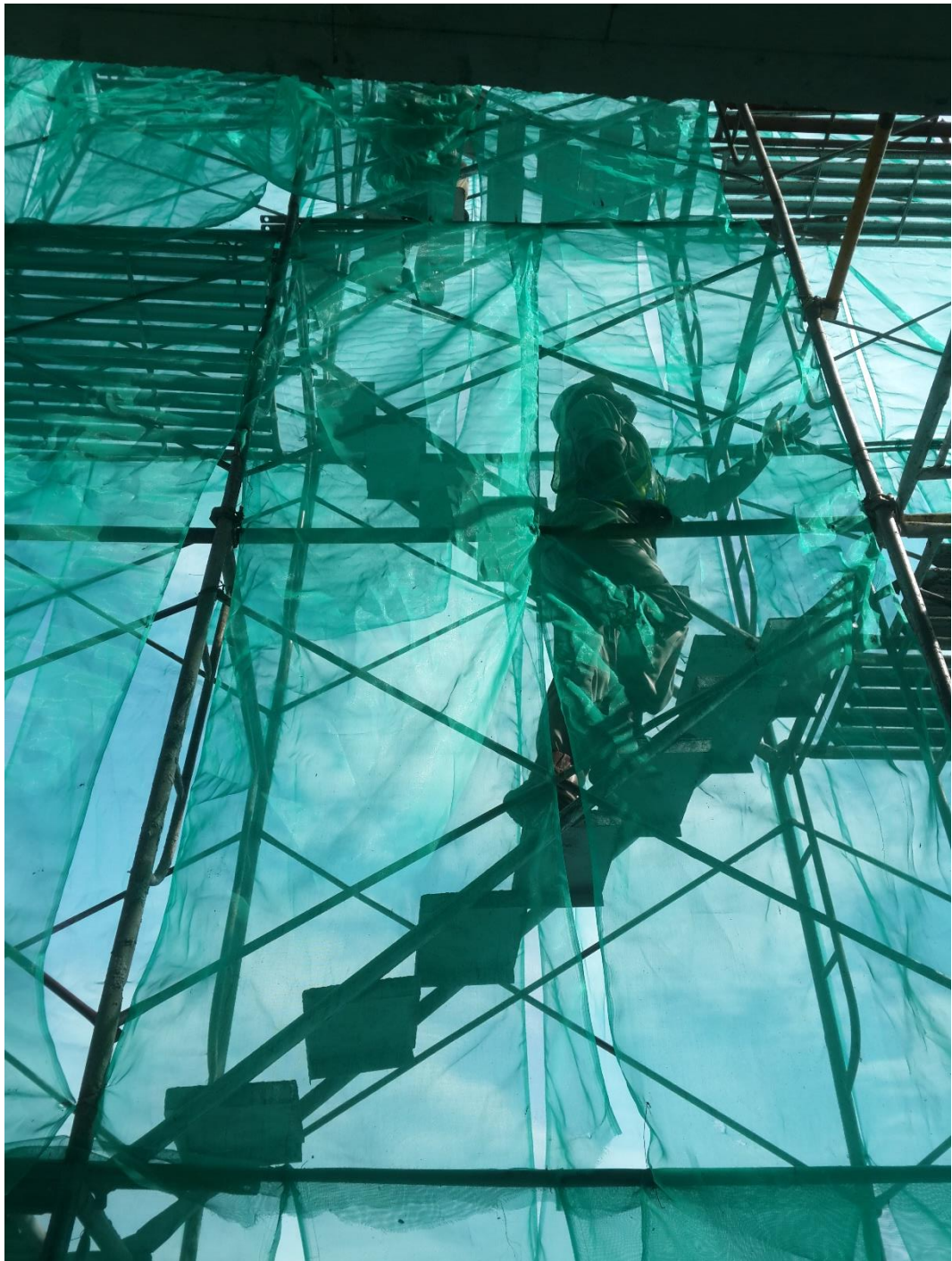
Lampiran 6: Proses pemasangan safety net pada tangga perancah
