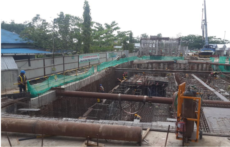
Lampiran 4: Proses pemasangan safety net pada railing
