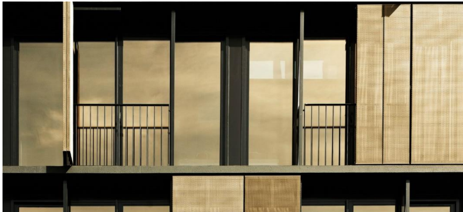
Gambar 2.30 Shutter pada selubung bangunan untuk menjaga privasi
