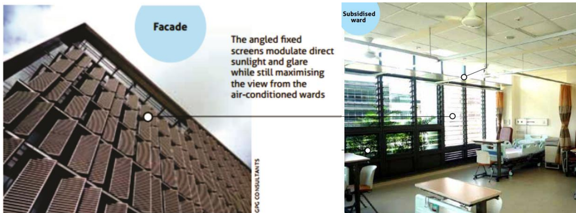
Gambar 2.19 Selubung bangunan yang memberikan kenyamanan dan mengurangi gangguan silau matahari (Reinke et al., 1989).
