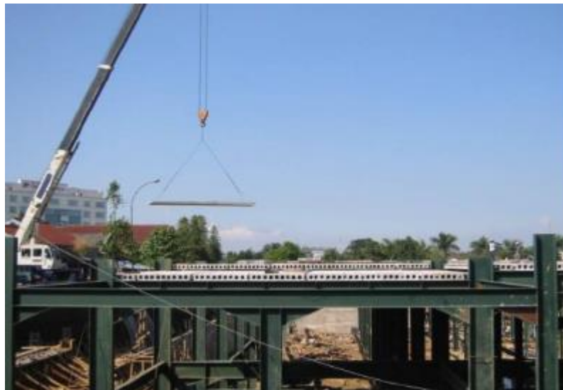
Gambar 3.4 Pengangkatan HCS menggunakan Mobile Crane
