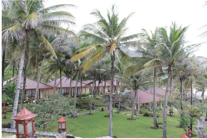
Gambar 2.8. Menunjukkan Aplikasi Desain Atap Limasan di Queen of The South dan Vegetasi penyerap air hujan sebagai respon desain di wilayah dengan curah hujan tinggi ( Sumber : www.agoda.com )
