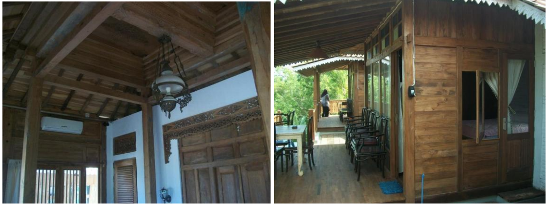
Gambar 2.25. Menunjukkan penggunaan material yang didominasi oleh Kayu yang terekspos, mulai dari elemen dinding hingga atap dan sistem penghawaan buatan dengan AC serta beberapa desain bukaan khusus yang membantu permasalahan termal
