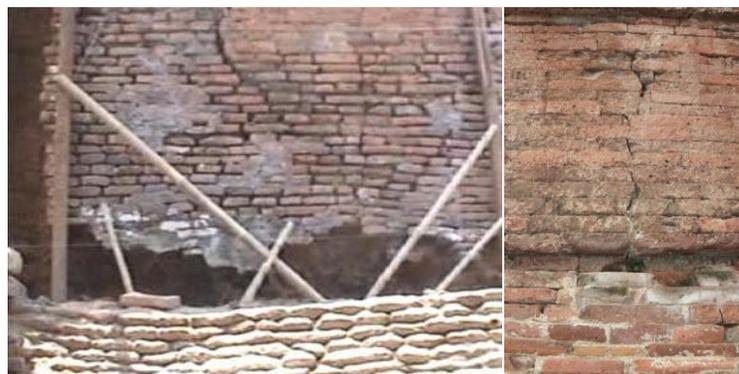
Gambar 3.2 Retakan akibat pengkerutan material bata
